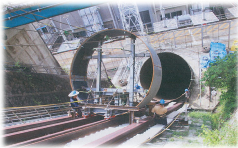
*岐阜丸山ダム水圧鉄管傾斜部①
